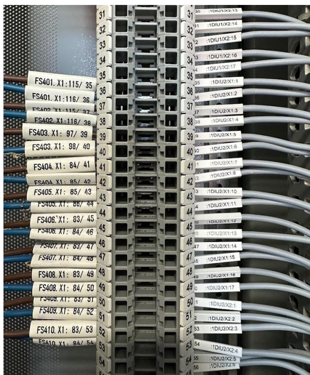
Zdjęcie nr 1 Przykładowe wykonanie oznaczników kablowych.
